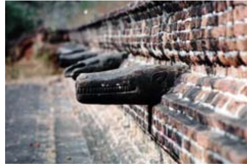
マカラ造形の配水管
